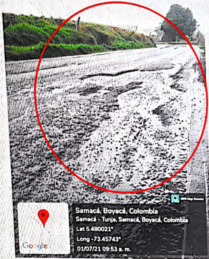
Imagen No. 17. Desgaste superficial, descascaramiento, cabezas duras.
